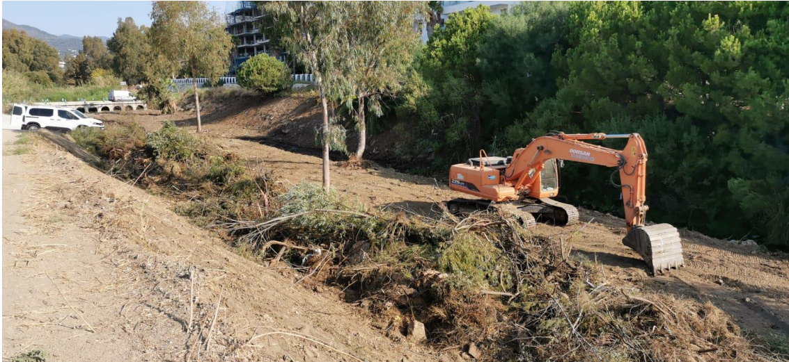
Figura 5: Tramo ya destruido del curso bajo. Se puede apreciar cómo se han dejado en pie las especies alóctonas de porte arbóreo mientras la vegetación autóctona ha sido completamente eliminada, esta actuación de ningún modo se corresponde a una supervisada por un técnico y además se está llevando a cabo con maquinaria pesada.
