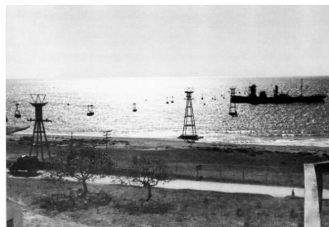
Sistema de torretas del Cargadero de Mineral
